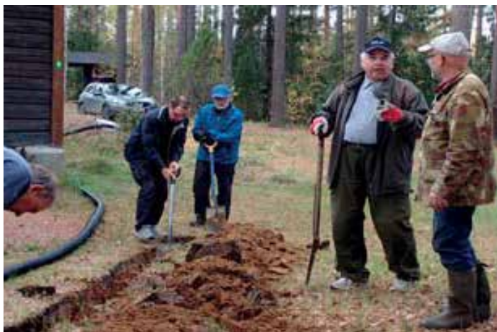
Syksillä kaivettiin Kalamajalla viemäriputkea jätevesikaivoon
